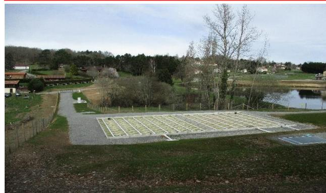
Les stations du BOURG et du BOUQUET étant obsolètes (Voir lettres d'information N°17 et N° 18), il a fallu les supprimer et faire réaliser une nouvelle station de 300 eqh, mais aussi une extension du réseau permettant à 11 habitations d'être reliées (en conformité avec le zonage actuel) à l'assainissement collectif. La municipalité a le plaisir de vous informer que ces travaux sont terminés. La mise en service, après les contrôles d'usage, est effective.
